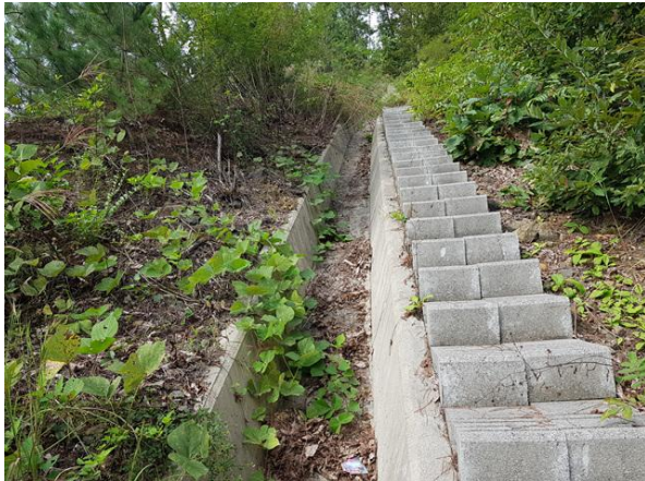
점검계단, 산마루측구 전경
